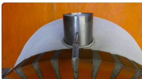
Fissaggio dello spiedo e rinforzo alla giunzione tra il camino e il forno.
